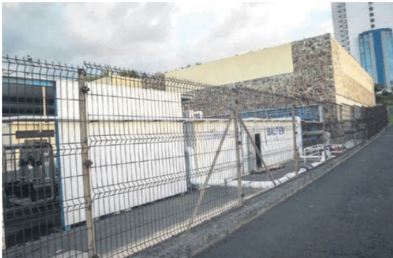
ESTACIÓN DEPURADORA DE PUNTA BRAVA, EN PUERTO DE LA CRUZ. Fran Pallero
